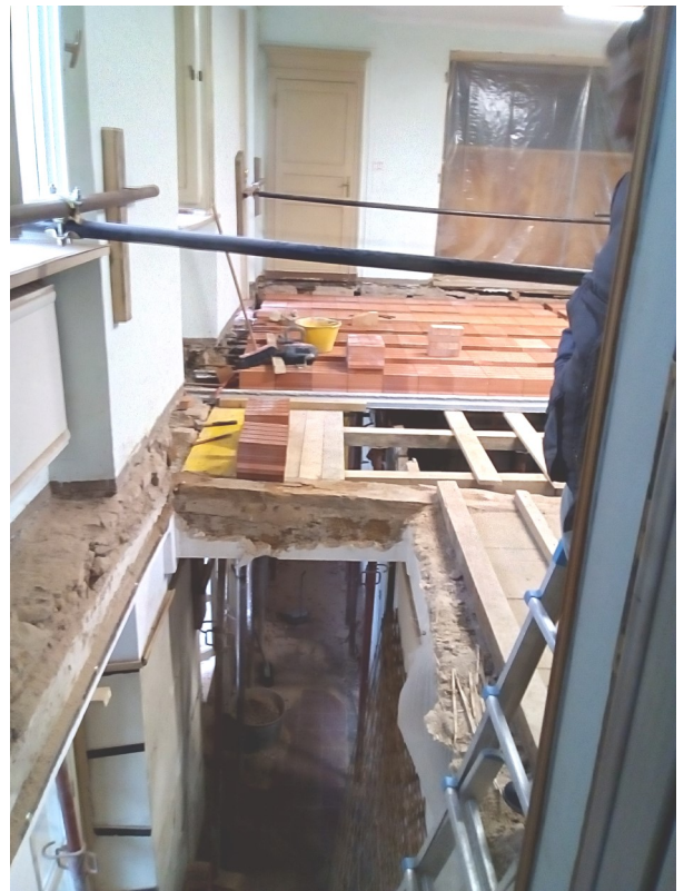
In alto vengono mostrati i lavori di rinforzo e rifacimento del pavimento della cappella. Sotto si può ammirare la cappella finita
